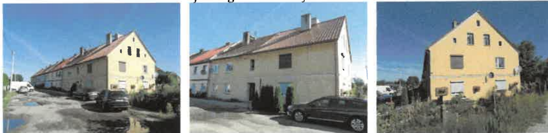
Dokumentacja fotograficzna budynku z dnia 12.08.2023r.
